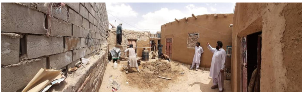
تصویر ۹: اجرای ارتقاء خانه‌های منتخب شیرآباد زاهدان
