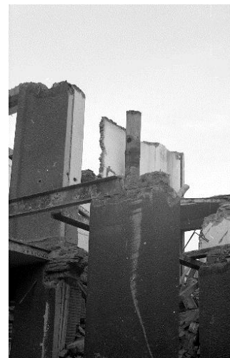
سازه خانه نظام‌مافی اثر گورکیان (ضمن تخریب)
