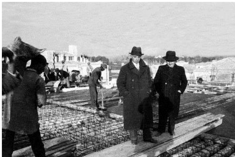
گورکیان در حال نظارت بر بتن‌ریزی (احتمالاً باشگاه افسران)
