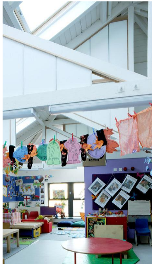
تصویر (۲۰۴): مهد کودک: پنجره‌های سقفی و بادبان‌های آکوستیکی ( http://aabarchitects.co.uk )
