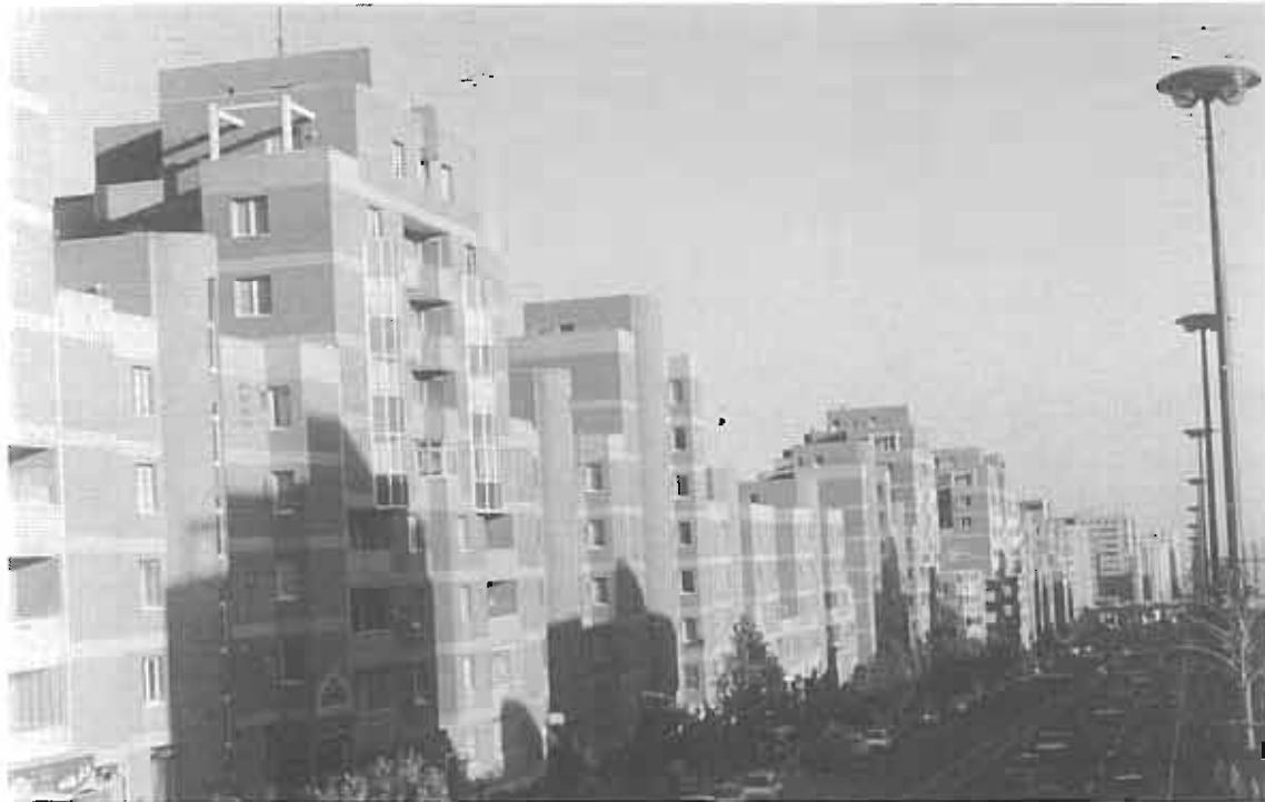
تابش نور غرب و سایه بلند ساختمانهای جبهه غربی
